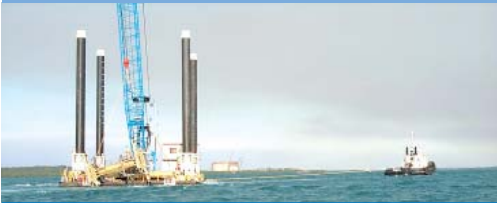
LNG Jetty Construction Equipment
